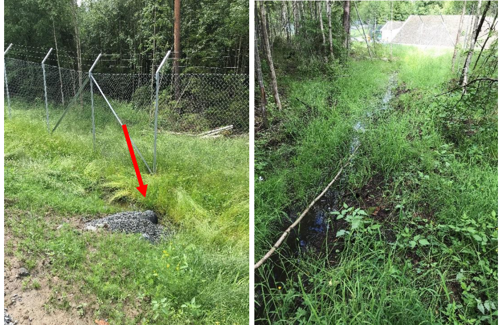
Figur 8. Bilde 7a viser med rød pil ca utløp fra bunkersområde ut mot grøftesiget i skogen. Trase for grøfta kan skimtes. Bilde 7b er tatt fra grøftesiget tilbake mot bunkersområdet.
