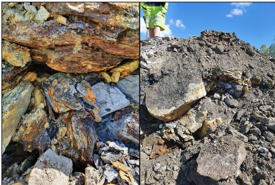
Figur 2. Fyllmasser med alunskifer ved utgraving av ny turvei i 2020 gnr/bnr 105/4. Bildet er tatt ved punkt PNB-A1 i Figur 3.
